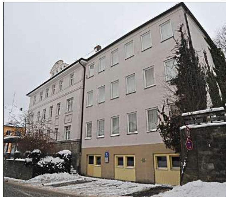
Der Anbau an das alte Amtsgebäude an der Pfluggasse wird abgerissen.
